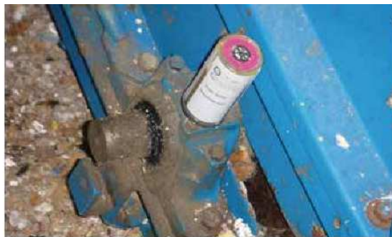
◆ 製紙工場 コンベヤー
