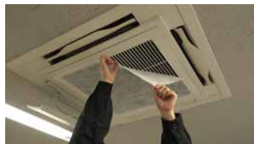
天井エアコンへの A600 取付例
